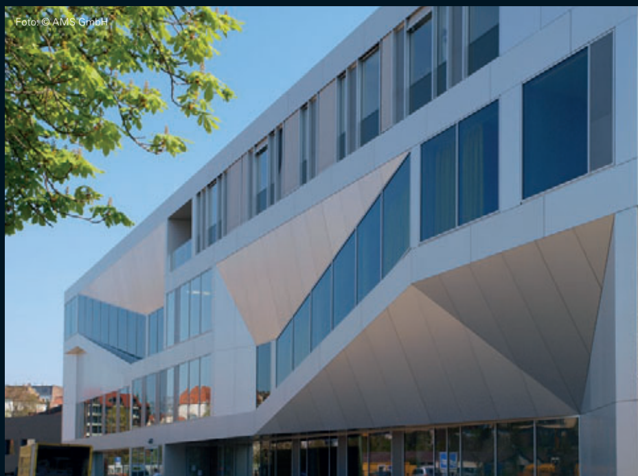
Hörsaal Campus Center der Universität Kassel
