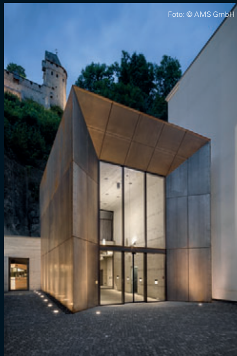
Portal, Burg Altena
